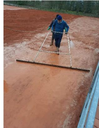
**Im Schritt 5** und dem Abtrocknen werden die Arbeitsvorgänge mit Schleppnetz, Wasser und Walzen immer wieder durchgeführt, bis zu min. 10 mal. Nachdem die Profifirma die ersten Durchgänge dieser Arbeit erledigt haben, setzt die Arbeit eigener Helfer über die nächsten Wochen ein.
