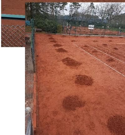
**Im Schritt 4** wird der neue Sand auf den Flächen der Tennisplätze gleichmäßig verteilt. Jetzt folgt das Einschlämmen des Sandes mit viel Wasser und die Glättung mit einem Gummischaber.
